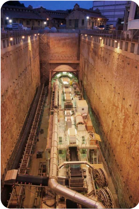
Línea 9 del Metro de Barcelona
